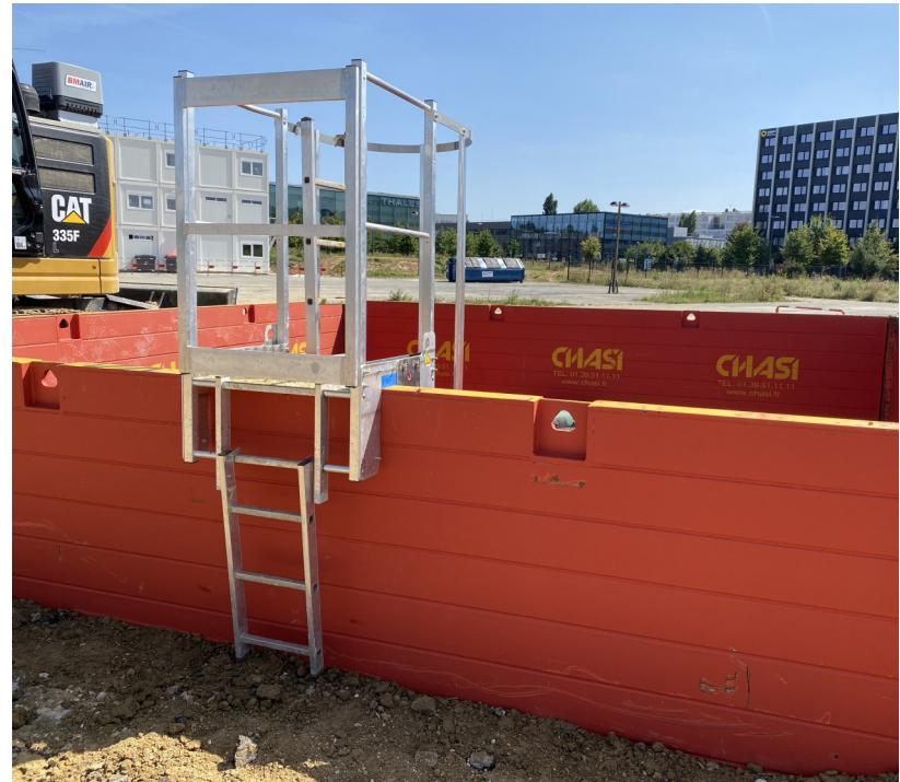
Module arrivée + Module intermédiaire 3 échelons + 10 échelons
