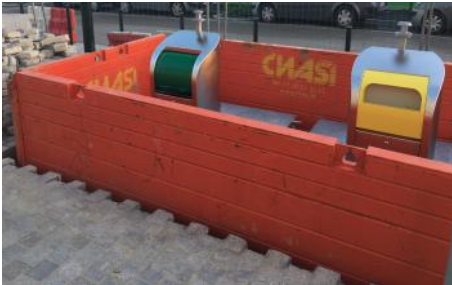
Pose de BAV : Coulissant simple avec poteaux d'angle
