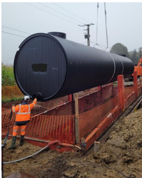
Pose d'une cuve de 15 m de long à 4 m de profondeur.
