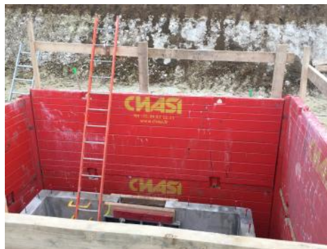
Coulée en fouille (20 m x 5 m)
