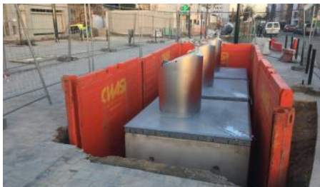
Puit 3,5 m x 3,5 m à 4,7 m de profondeur
