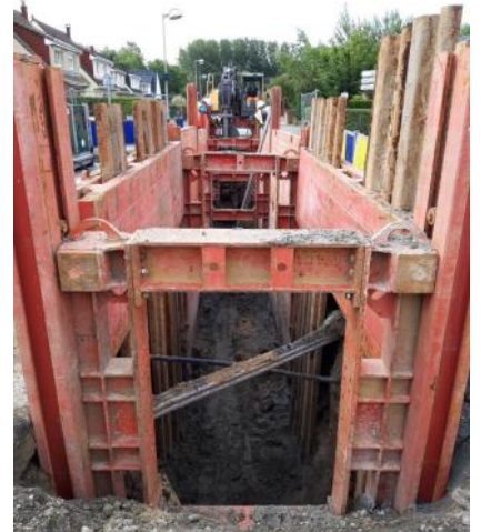
Pose d'une cuve (15 m de long)
